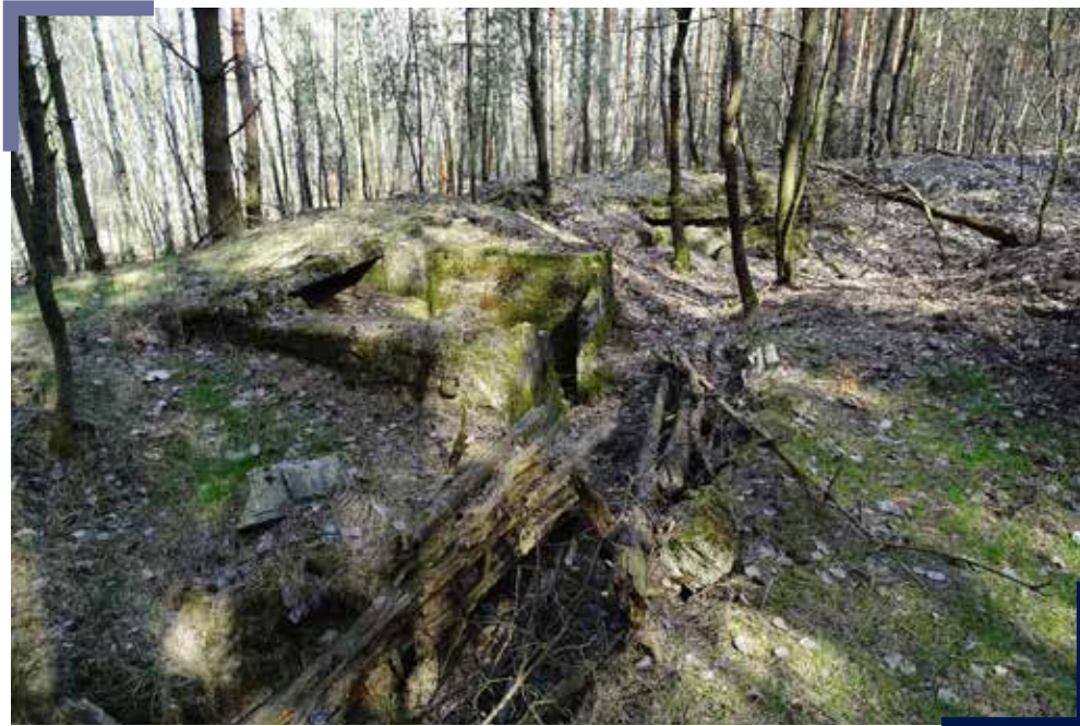
Ryc. 3. Zachowane fortyfikacje ziemne z 1914 roku w rejonie punktu oporu na Miłostowie: po lewej betonowe stanowisko obserwacyjne o stropie wzmocnionym szynami kolejowymi (obecnie zdewastowane), w głębi zachowana betonowa nisza chroniąca znajdujących się w niej żołnierzy przed ogniem ze szrapneli; widoczny okop, którego ślad poprawiono i wykonano nowe fortyfikacje połowe późną jesienią 1944 roku, z reliktnymi drewnianego szalunku prawdopodobnie z tego okresu
