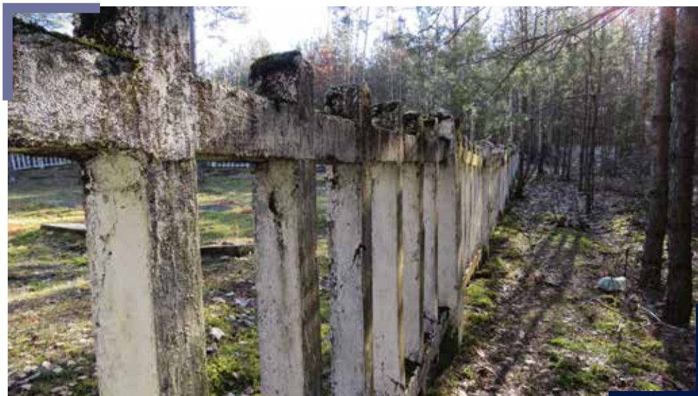
Ryc. 5. Betonowe ogrodzenie wykonane w latach 20. lub 30. XX w. przez zakład betoniarski w Ostrołęce na zamówienie białostockiego Urzędu Wojewódzkiego. Ogrodzenia takie były wykorzystywane w regionie do grodzienia miejsc pamięci i w wielu miejscach zachowały się do dzisiaj. Na fotografii ogrodzenie cmentarza wojennego w Wachu, gm Kadzidło
