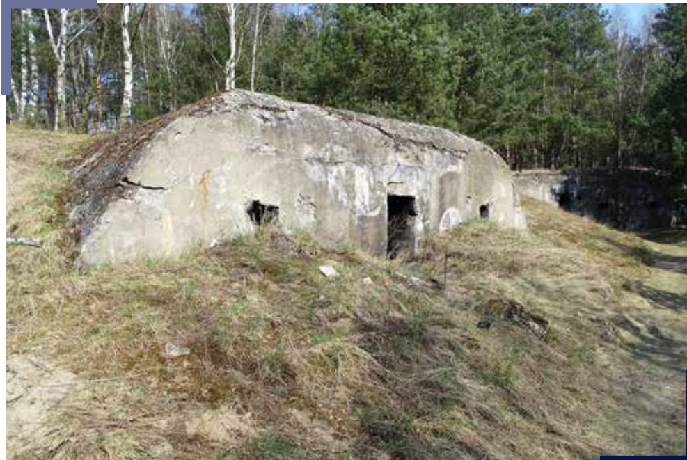
Ryc. 1. Dwuizbowy betonowy schron z lat 1913/14 o konstrukcji szkieletu z blachy falistej zalewanej betonem, który mógł pełnić różnorodne role, takie jak m.in. ukrycia dla piechoty, punktu dowodzenia czy opatrunkowego
