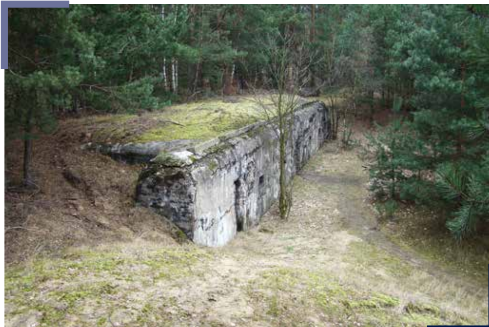
Ryc. 2. Schron piechoty z lat 1913/14 wykonany w technologii betonowej, którego konstrukcję stalową wzmocniono szynami kolejowymi
